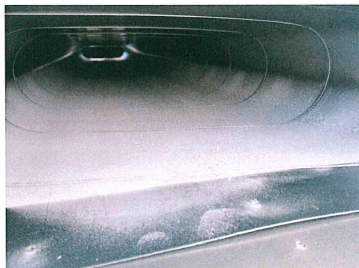
Bild 3: zu prüfende Leitungen nach Anschmutzung
